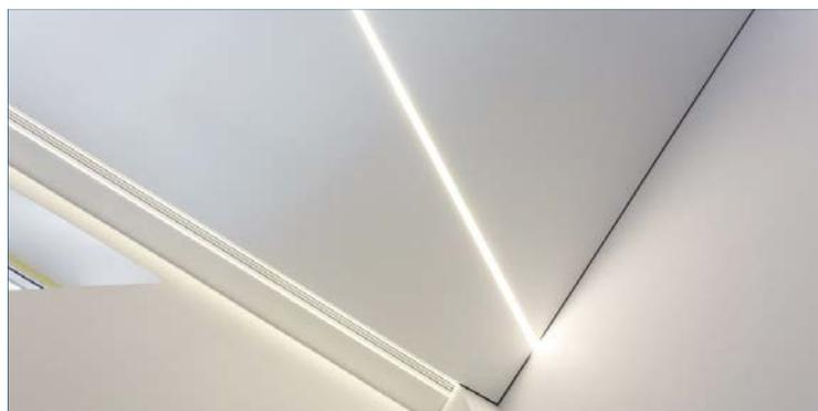
Acabamento em alumínio anodizado com pintura a pó branca
