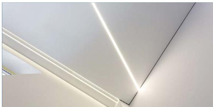
Acabamento alumínio anodizado com pintura pó branca.
